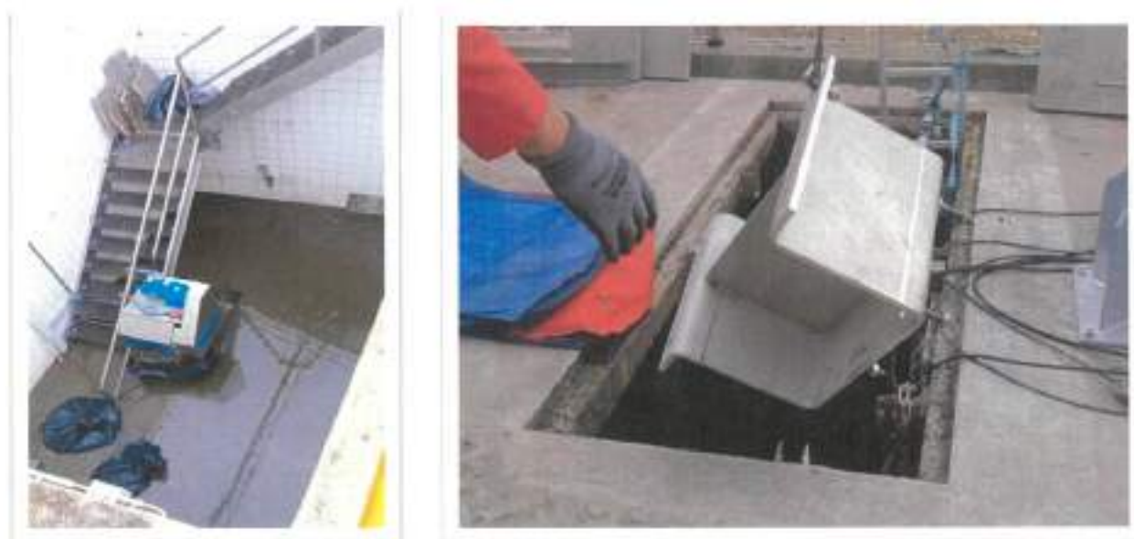
Figura 38 – Emp. Fornecimento e Montagem de Substituição de Equipamentos Eletromecânicos da Z. Norte – Lt 3
