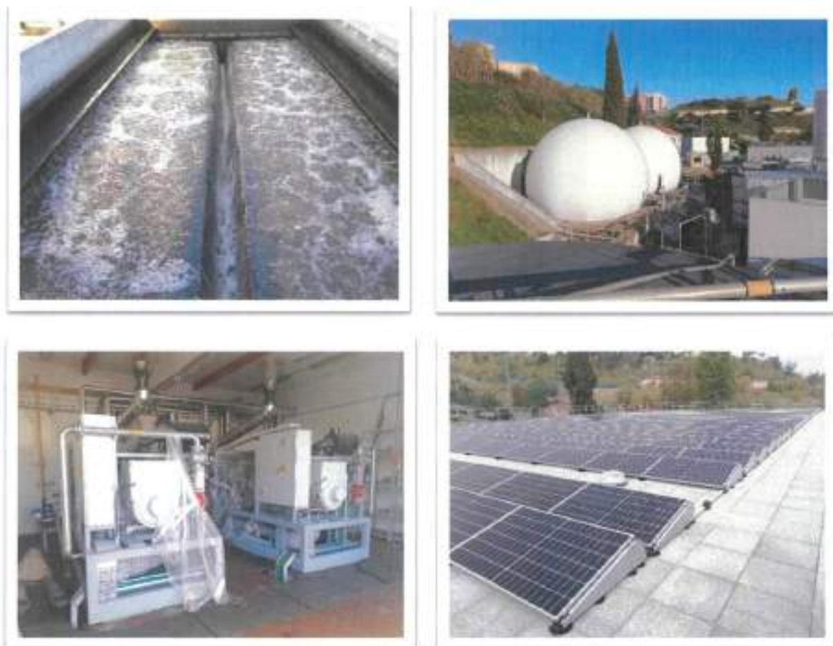
Figura 33 - Empreitada de Conceção-Construção da Beneficiação da FA de Chelas - Fase I
