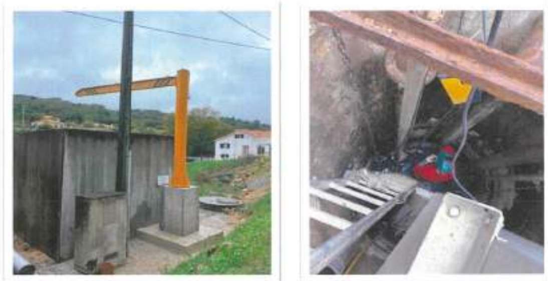
Figura 37 – Emp. Fornecimento e Montagem de Substituição de Equip. Eletromecânicos Zona Norte AdTA - Lt 2
