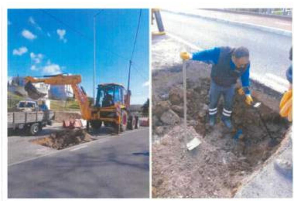
Figura 40 - Empreitada de Reabilitação de Câmara de Visita do Emissário das Marianas - Fase I
