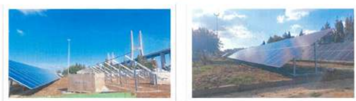
Figura 39 - Empreitada de Fornecimento e Instalação de Centrais Fotovoltaicas nas FA de Alcântara e Beirolas
