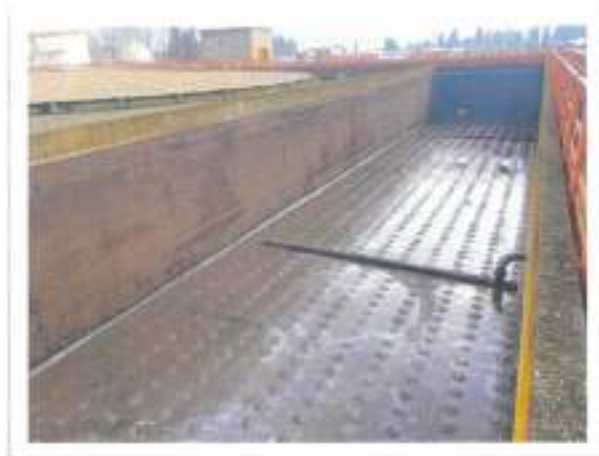
Figura 43 - Empreitada de Fornecimento e Montagem de Sistema de Arejamento para a FA de Beirolas
