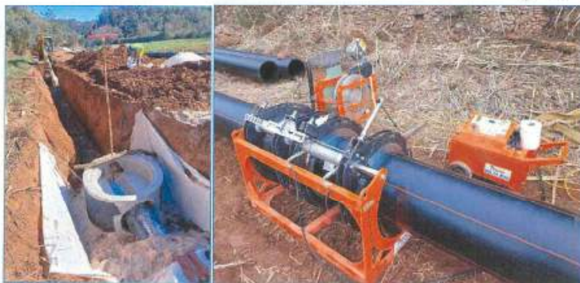
Figura 66 - Empreitada de Execução dos Interceptores e Sistemas Elevatórios Fase III do Subsistema de Foz de Lizandro - Restantes intervenções
