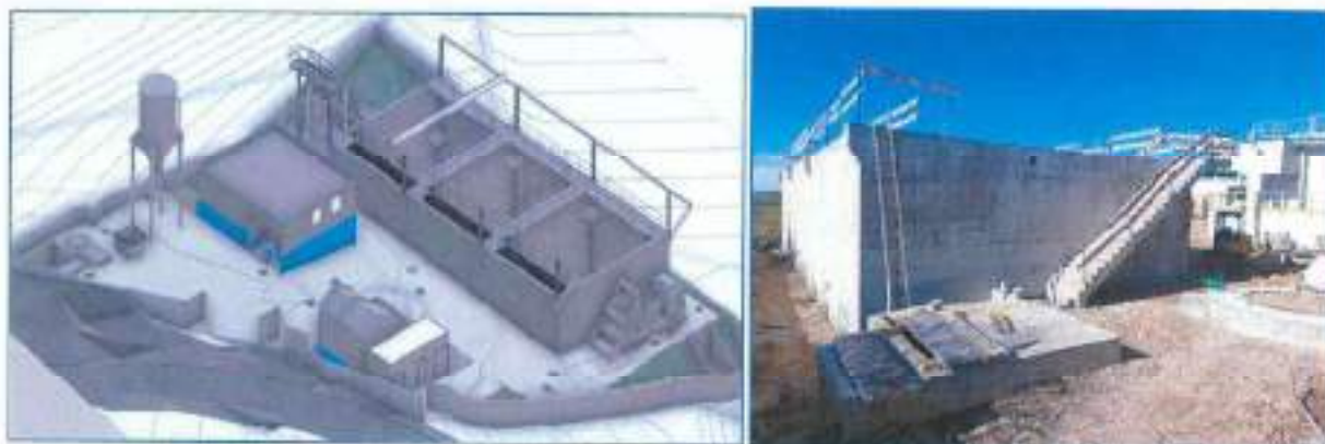
Figura 84 - Empreitada de Conceção-Construção da Remodelação da ETAR da Encarnação
