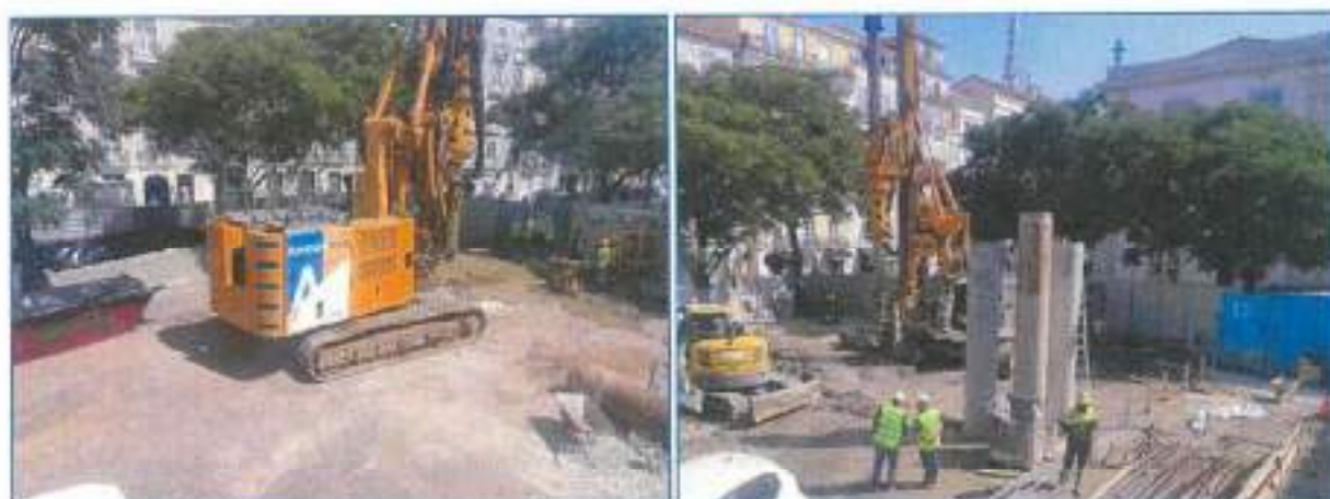
Figura 63 – Empreitada de Benfeitorias nos Sistemas Elevatórios do Subsistema de Alcântara - EE Terreiro do Trigo
