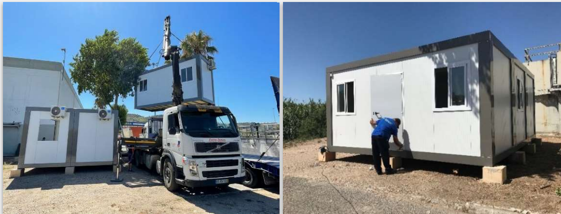
Figura 5 - Instalação dos contentores – Escritório Sede em Frielas.
